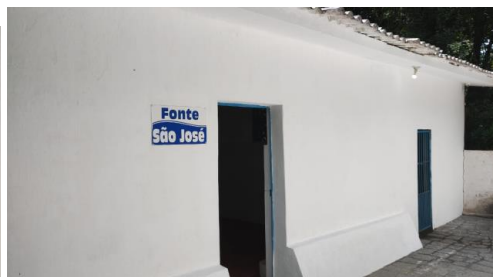
Casa de proteção
