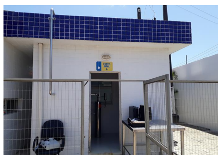
Foto 02 - Casa de Proteção
